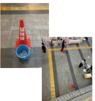
区役所・雨漏りの現場
